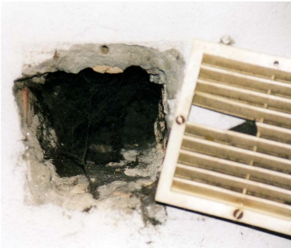
Apertura di ventilazione in condizioni critiche sia per la realizzazione, sia per le condizioni di mantenimento.
