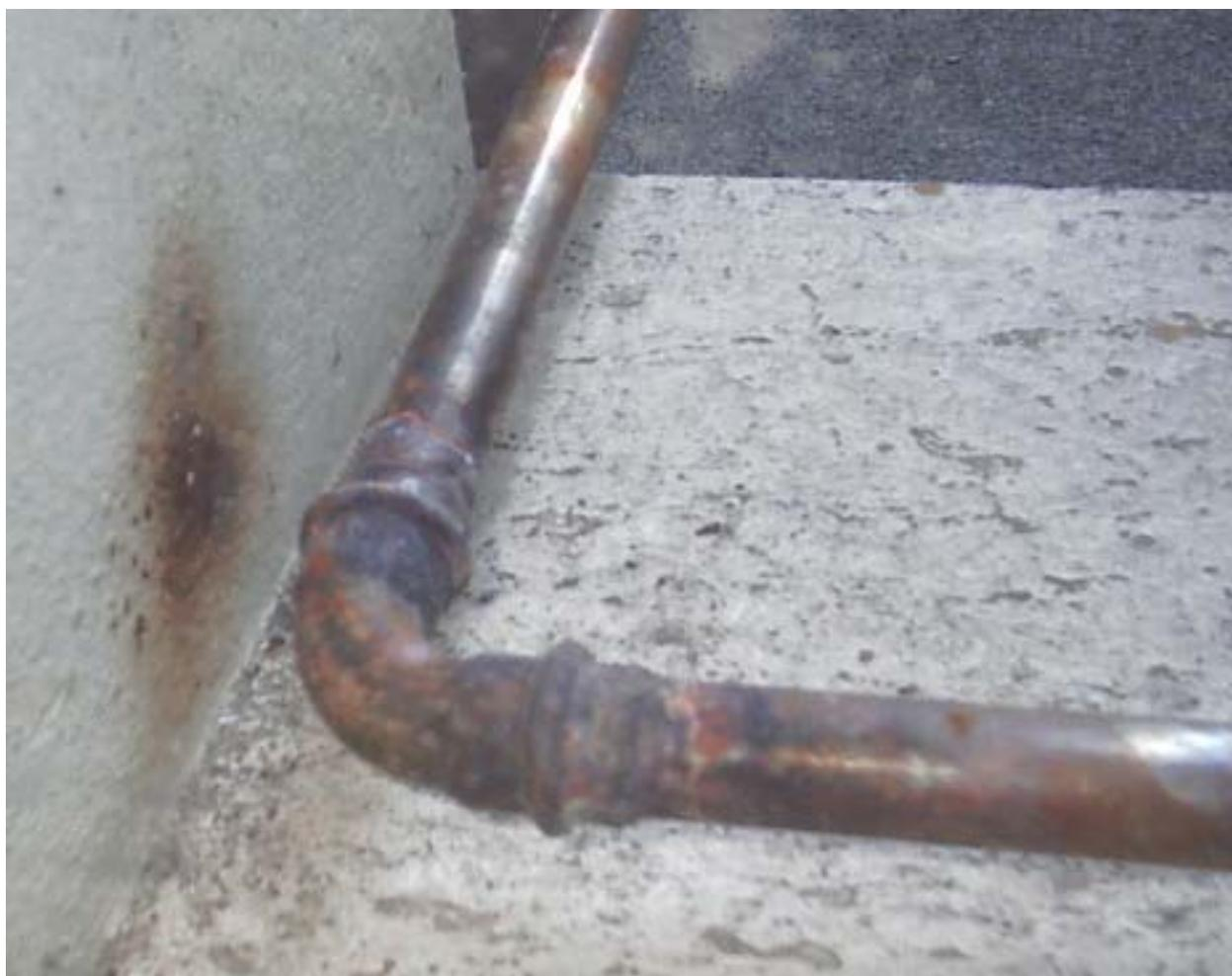
**1 Giunzione inadeguata perché in esecuzione brasata anziché a pressione come necessario in relazione al tipo di raccordo presente**
