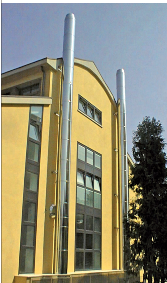
ESEMPIO DI INSTALLAZIONE di un camino senza guarnizioni con fumi umidi.
