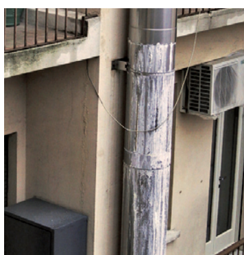
ESEMPIO DI INSTALLAZIONE di un camino senza guarnizioni con fumi umidi.
